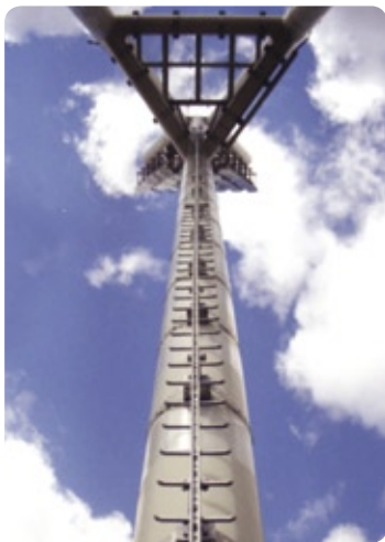
Flutlichtmast zur Stadionbeleuchtung mit Steigleiter aus verzinktem Stahl
