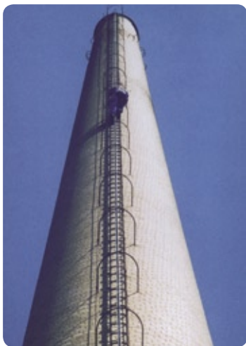
Schornstein mit nachgerüsteter Führungsschiene
