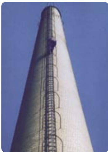
Skorsten med ny styrskena på stegen.
