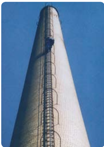
Chimenea con rail de anclaje montado a posteriori
